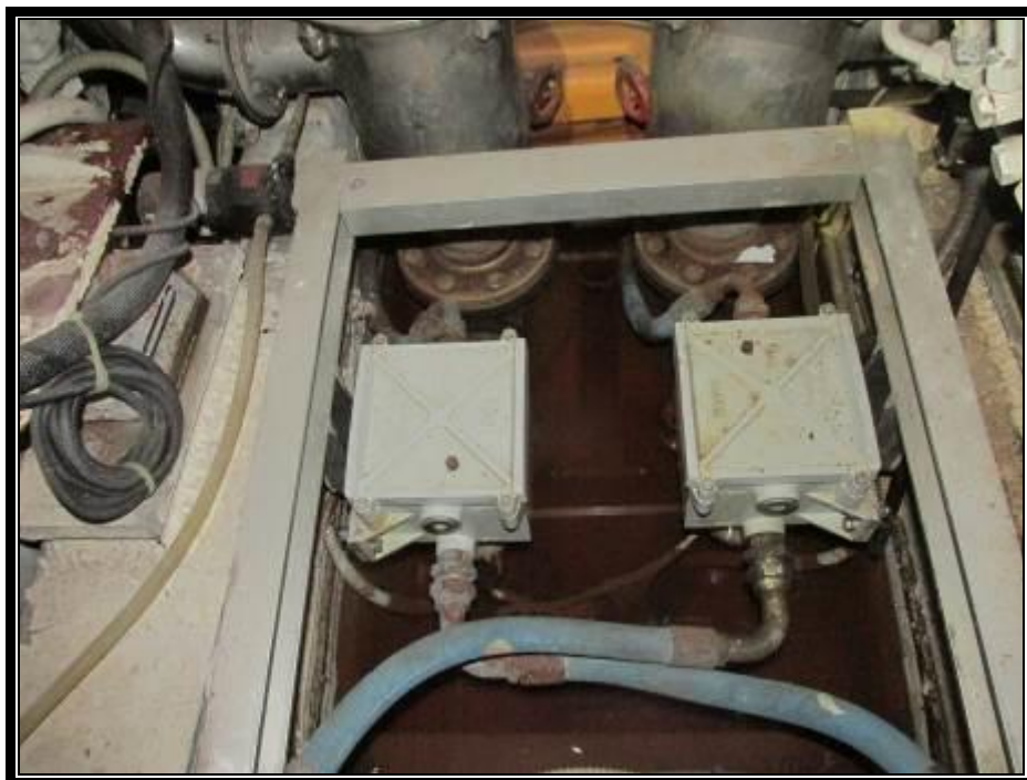
Slika 33. Potpuno naplavljena strojarnica tijekom više godina
