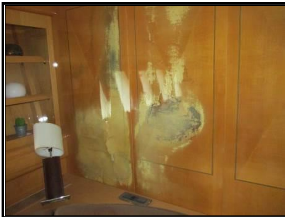
Slika 22. Oštećenje interijera prokišnjavanjem
