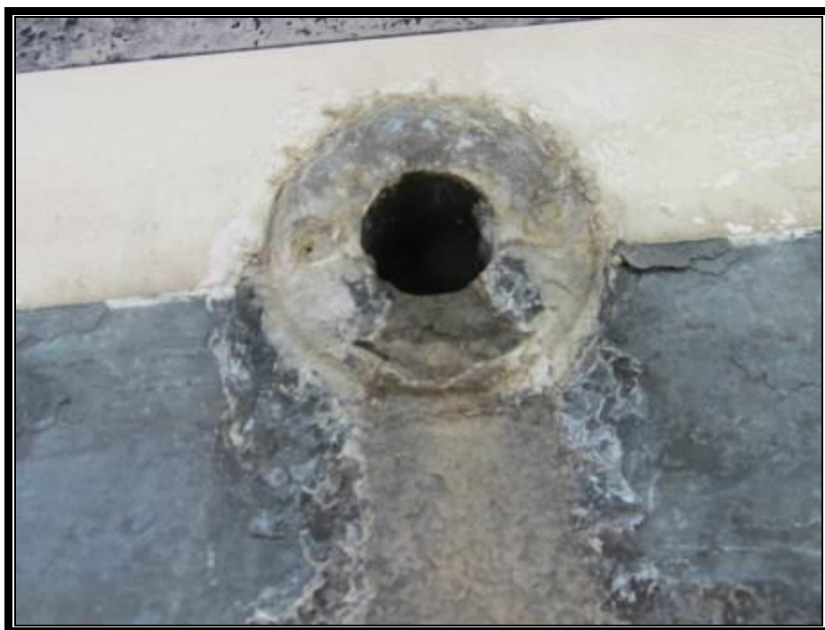
Slika 5. Potpuno korodirani ventili i oplatni otvori
