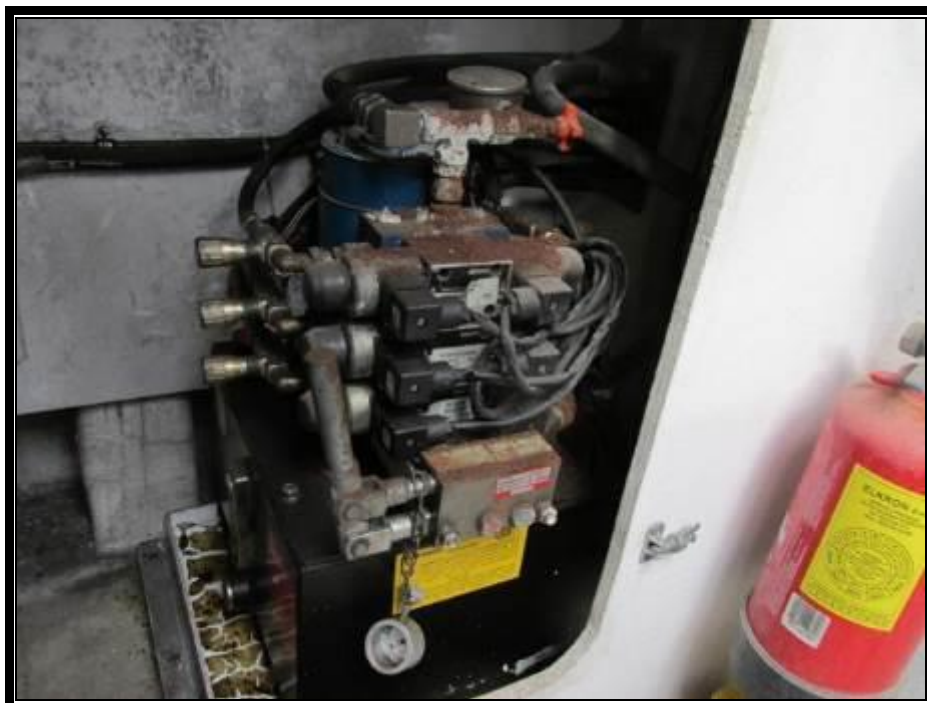
Slika 37. Hidraulična oprema oštećena korozijom
